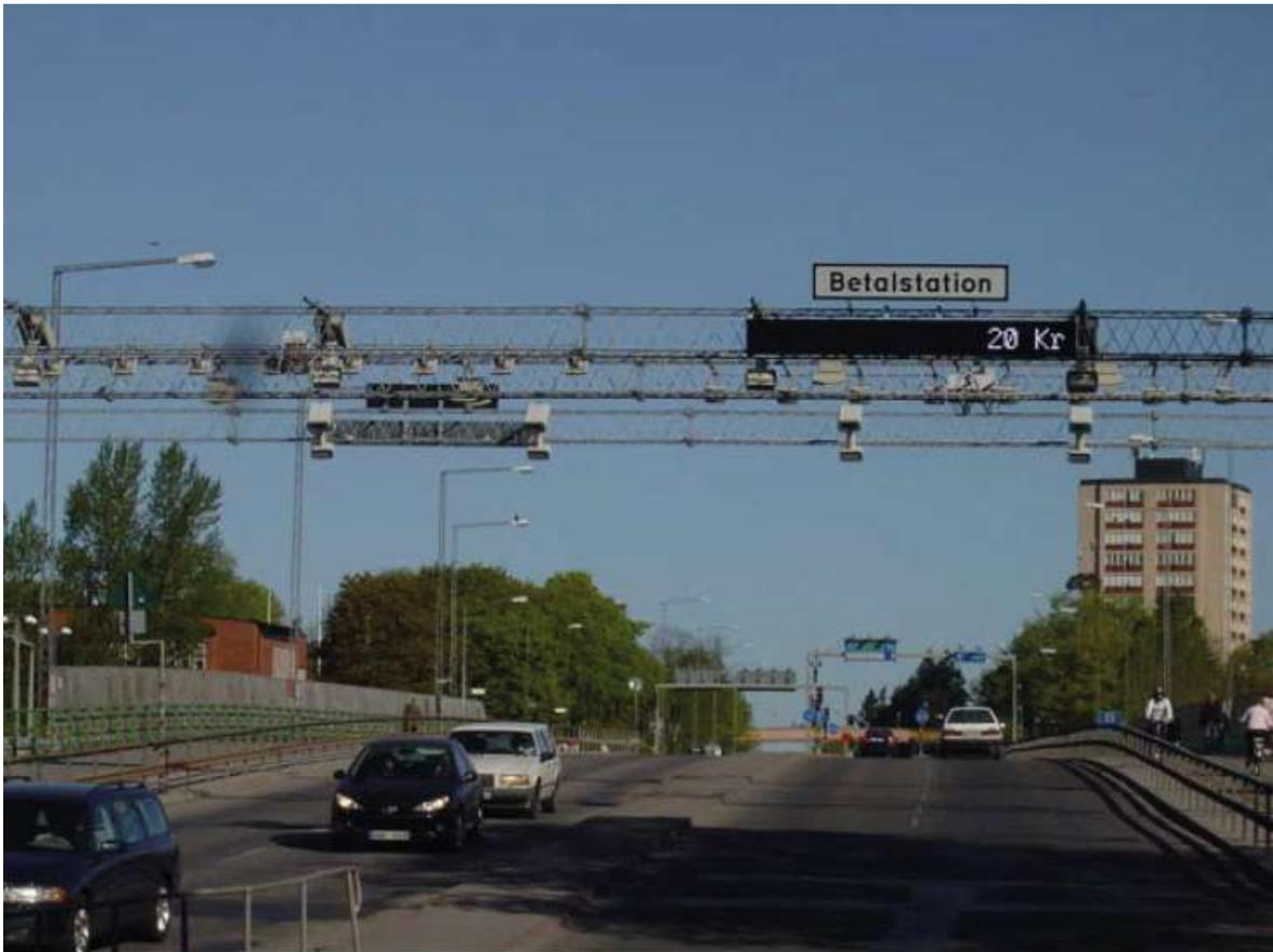
Figura 1 Ejemplo de instalación de tecnología ANPR.
